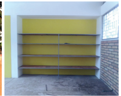
Eines der Klassenzimmer (Rohbau)
